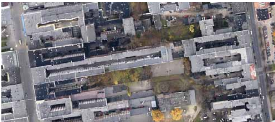
Ilustracja nr 12. Łódź. Kwatera zabudowy między ul. Piotrkowską a Sienkiewicza. Przykład zachowania pierwotnego układu parcelacyjnego Osady Łódzkiej. Najdłuższe podwórko w łódzkiej kamienicy (w centrum, ul. Piotrkowska 82).
